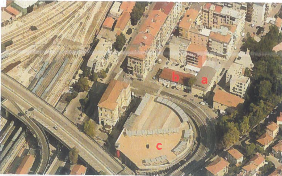
Fig. 3 – Immagine dall'alto dello stato di fatto dell'intera APC5 con l'individuazione di:
