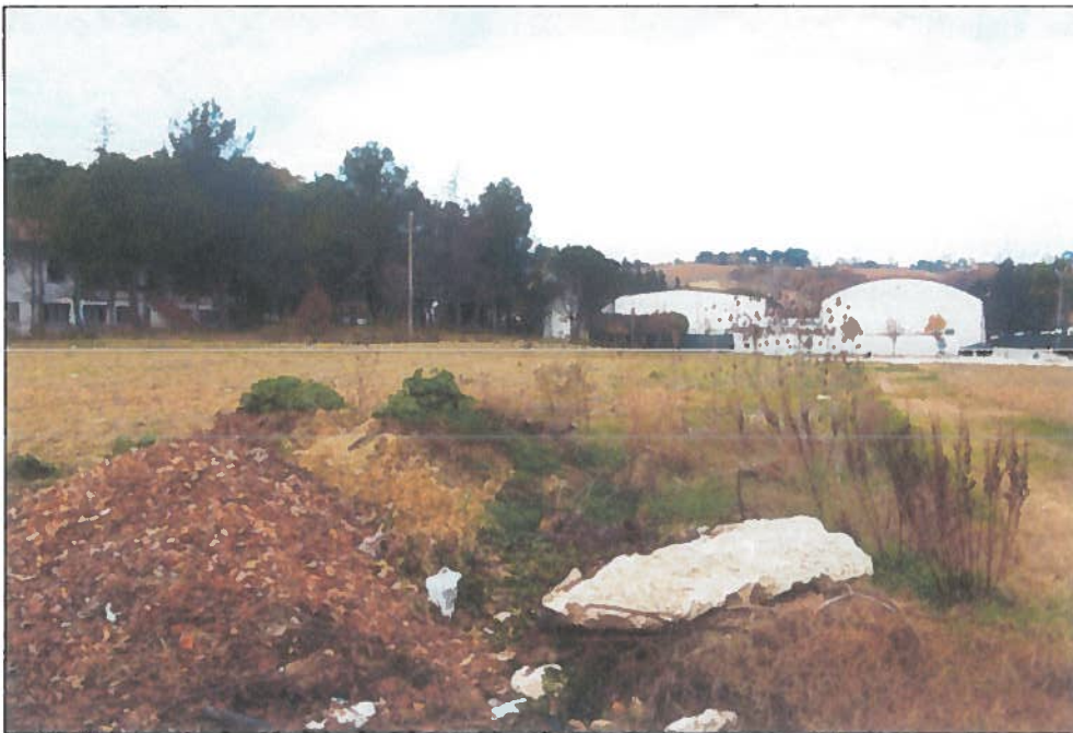
Capannoni agricoli lungo la s.p.7 Cameranense – zona Boranico.
